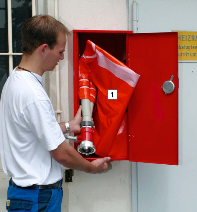
Schnell einsatzbereite, mobile Abdichtung (Länge: 2 Meter) für Türen, inklusive Stahlschrank zur Aufbewahrung am Einsatzort
