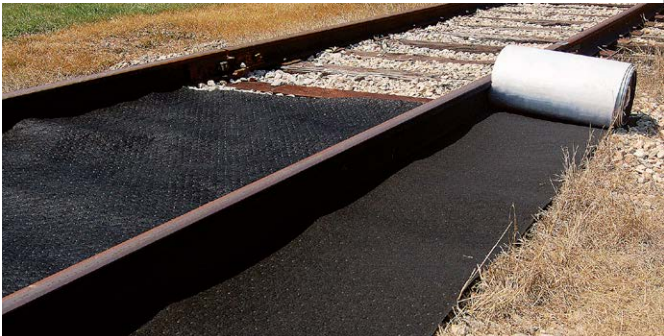
Anwendung auf Bahngleisen: Die breite Rolle passt präzise zwischen die Schienen. Mit der schmalen Rolle werden die Seitenbereiche geschützt.
